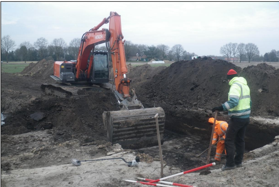
Figuur 2: Aanleg van de werkput.
